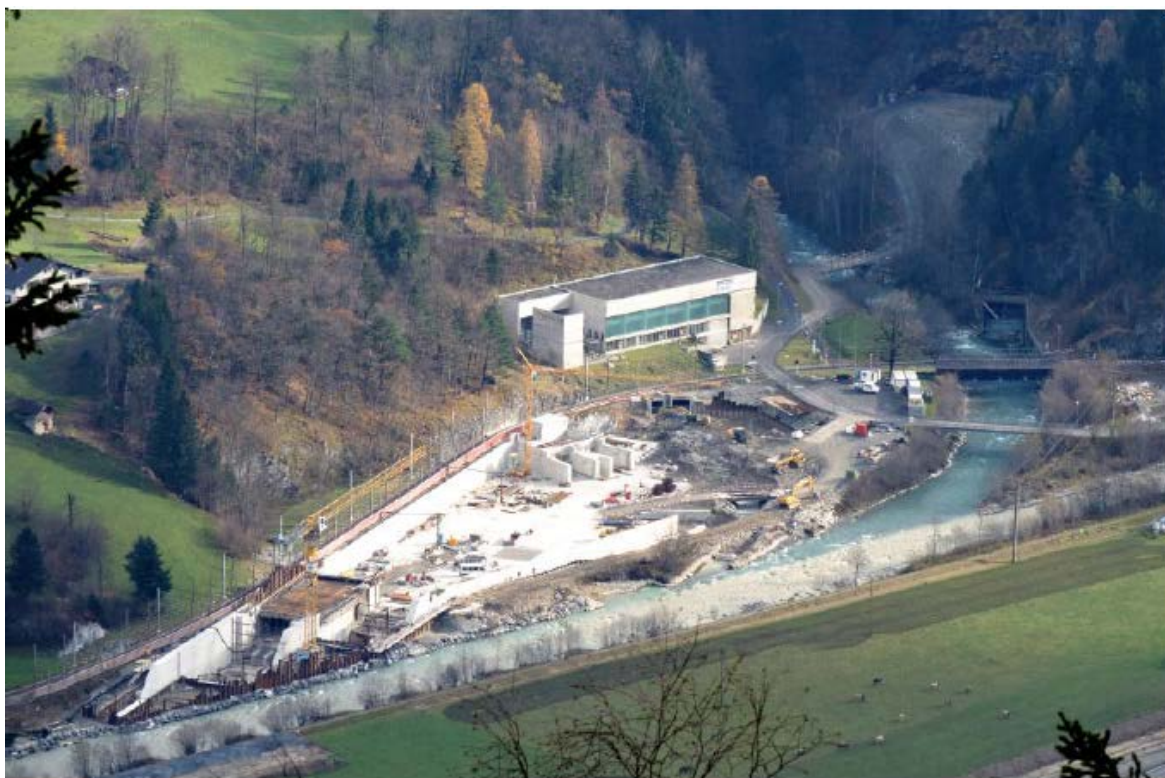
Figur 9: Fodrøyingsbasseng under bygging ved Innertkirchen kraftverk i Sveits. Kilde: IM Engineering 38
